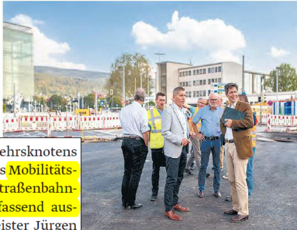
Erster Bürgermeister Jürgen Odszuck (r.) überzeugte sich bei seiner Baustellentour vom Fortschritt der Arbeiten am Verkehrsknoten Hauptbahnhof. (Foto Dittmer)
