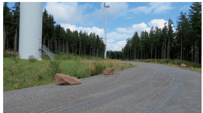
Bild 4: Wegebau und Geländemodellierung für Windkraftwerke auf dem Gipfel des ursprünglich dicht bewaldeten Stillfüssel bei Waldmichelbach
